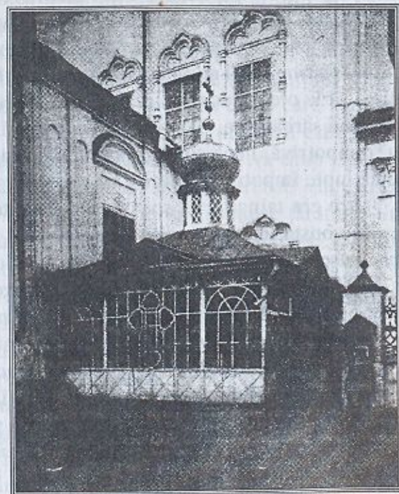
Capela construită deasupra mormântului Sfântului Serafim. Aici au rămas moaștele Sfântului până la canonizarea sa în 1903.
